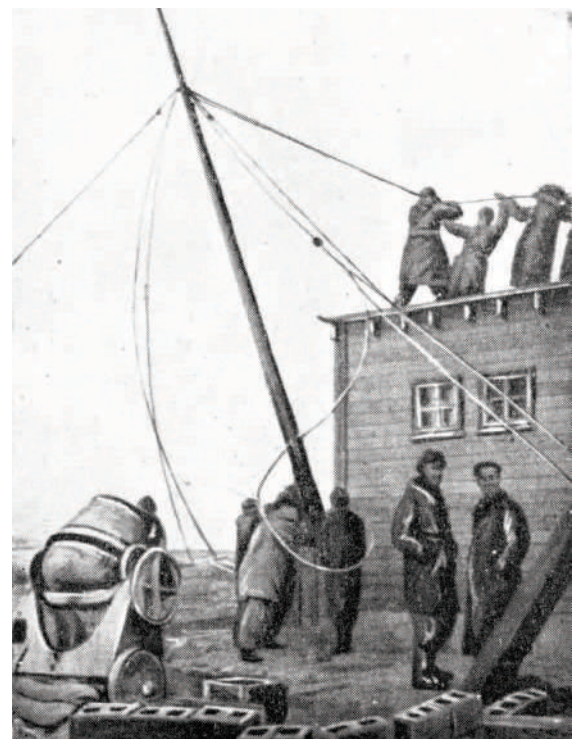
BASE MILITAR O'HIGGINS, INSTALACIÓN DE ANTENA DE TELECOMUNICACIONES EN 1948
