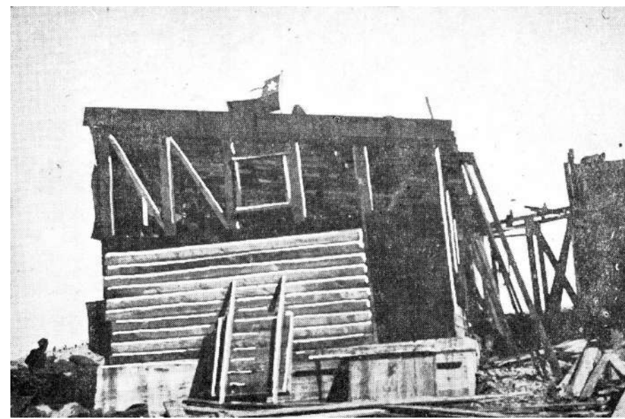
PROCESO DE CONSTRUCCIÓN DE LA BASE Construction process of the Base
