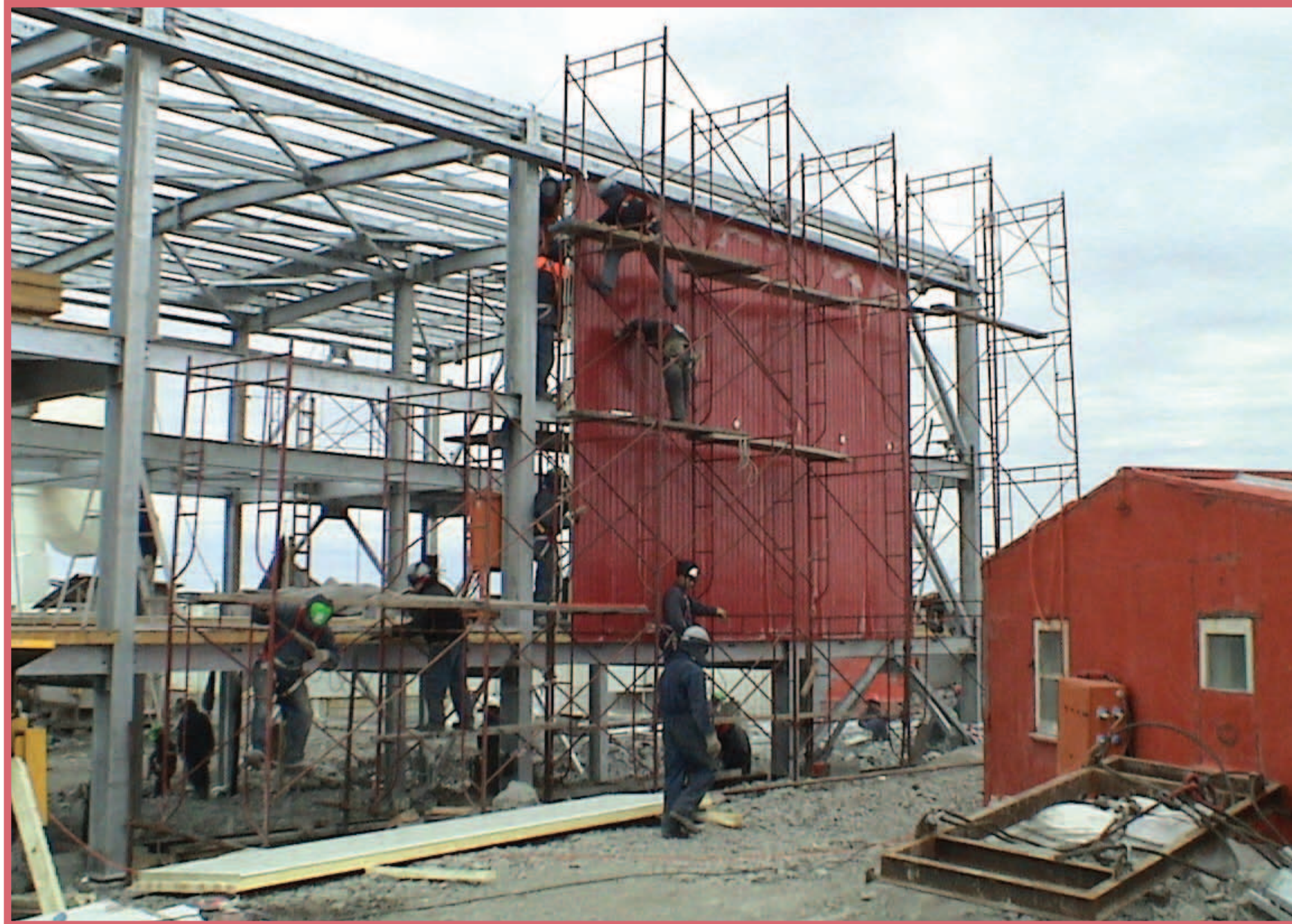
VISTA DE LOS AVANCES DE LA OBRA DE CONSTRUCCIÓN DE LA BASE NUEVA EN EL AÑO 2002
