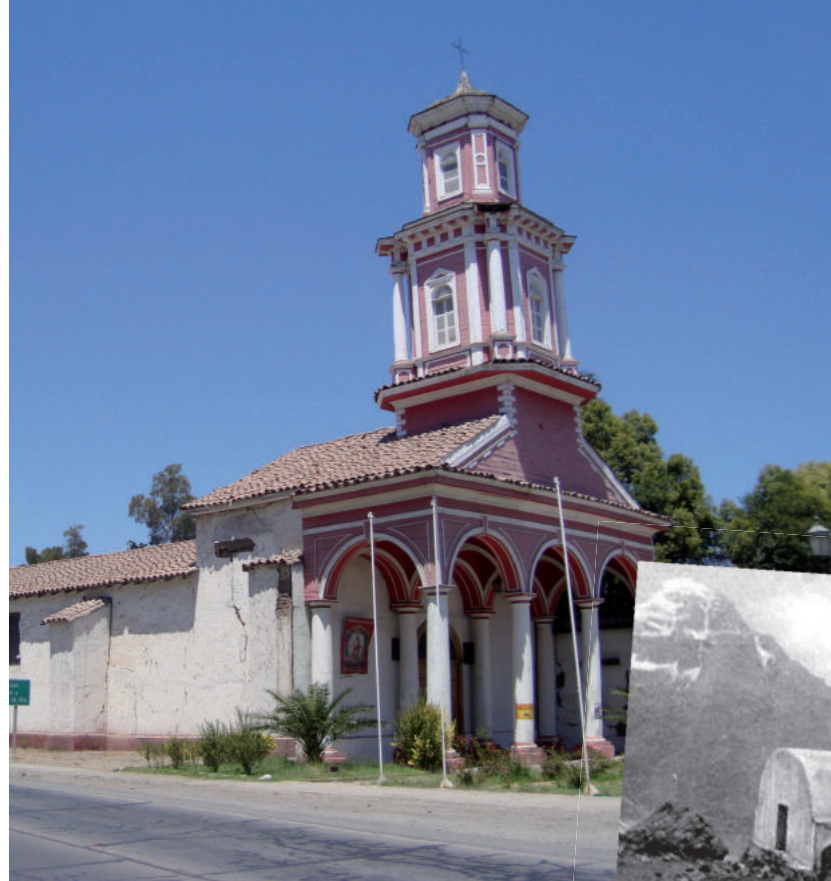
Iglesia de Curimón, cerrada por daños producto del terremoto de 2010.
